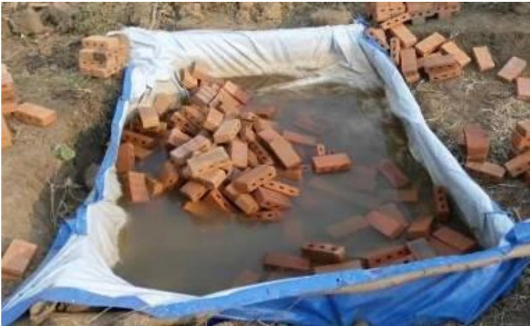
Les briques doivent être trempées dans l'eau pendant au moins 1 heure avant de les poser.
