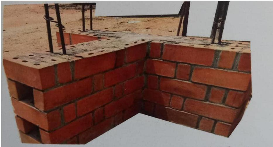
Cette technique de maçonnerie de briques consiste à monter les murs en agencant les briques afin d'aménager des alvéoles dans le mur. Les briques sont maçonnées sur champs. Elle est de plus en plus utilisée de nos jours pour faire face aux problèmes de logements et autres infrastructures en diminuant les coûts de construction et propose aussi une solution alternative aux techniques à haute consommation énergétique.
